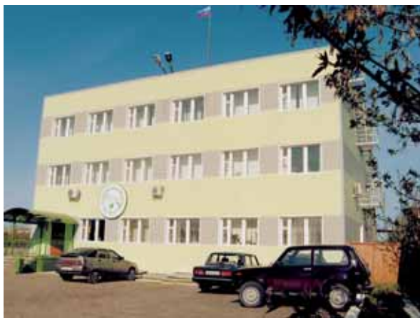
Здание управления. 2008 г.
