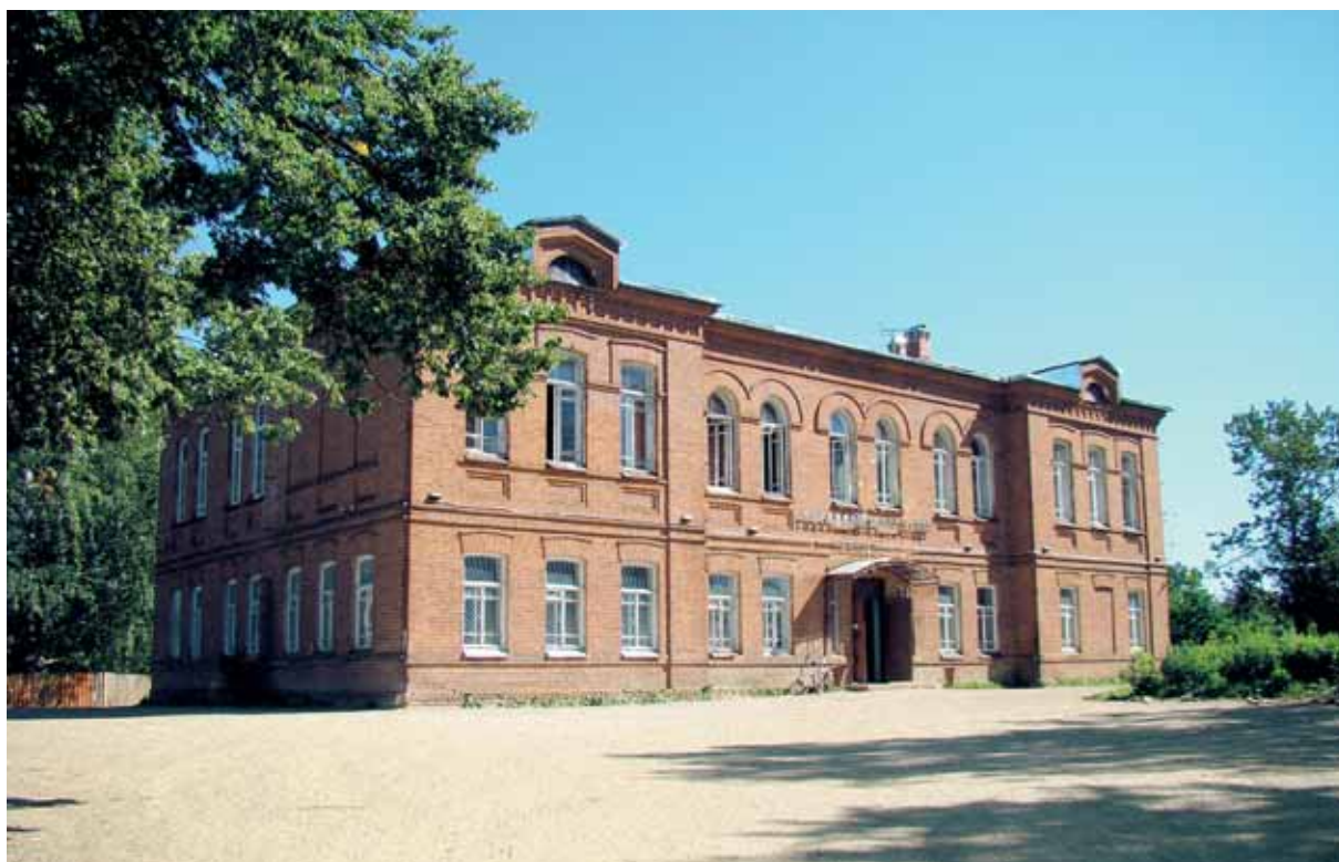
Торговый центр. 2007 г.
